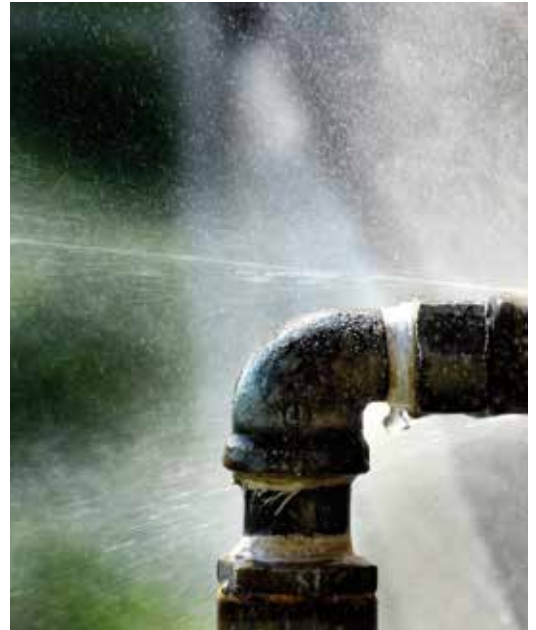
Evita las corrosiones por punto.
