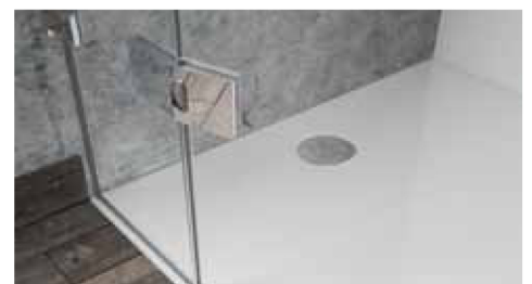
Bisagra, apertura a 180° Mejora el acceso y la limpieza
