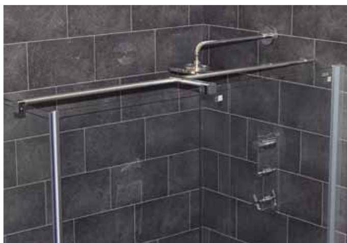
Opción Fijación en T: Para los casos que no podemos instalarla con la barra estabilizadora a pared contraria.
