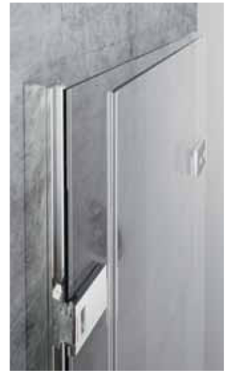
Detalle en plegables Apertura interior y exterior
